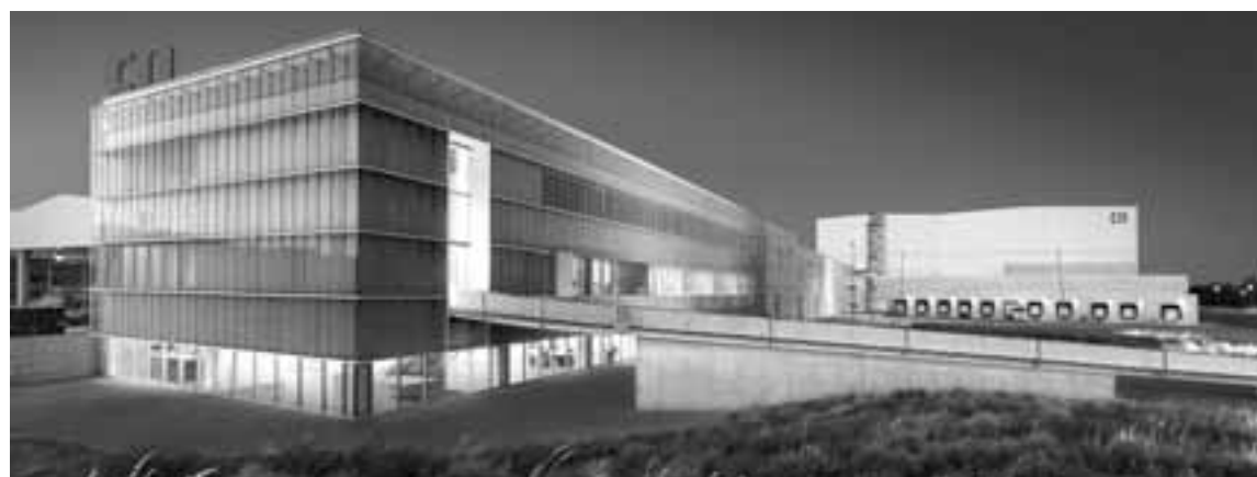
Instalaciones de Congelados de Navarra en su planta de Fustiñana.
